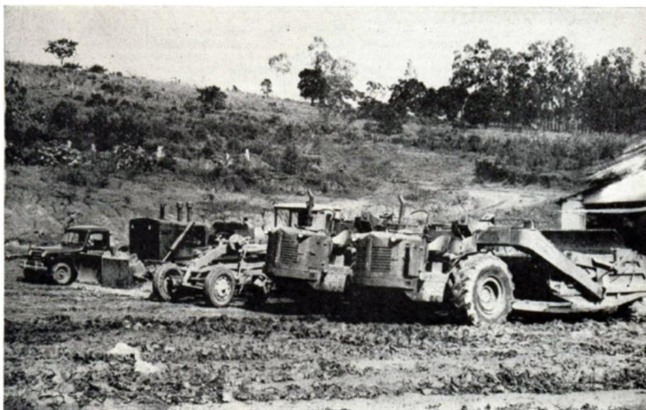
**Fig. 2.** Máquinas da Rodovias e Obras S.A., Rodobrás, no serviço de terraplanagem do Pátio da Estação Rodoviária. Fonte: Revista Brasília, 1957.
